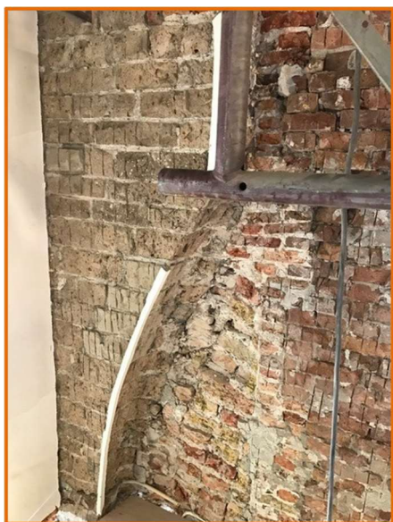
Op de linker foto de stenen achter de stuclaag
